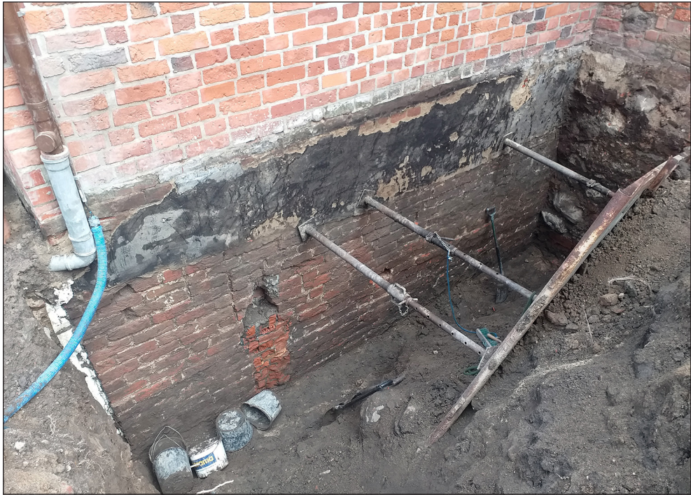
Ryc. 3. Ściana fundamentowa plebanii NMP Królowej Świata w Stargardzie odkryta w trakcie prac związanych z odwodnieniem. Fot. M. Szeremeta, MAH w Stargardzie
